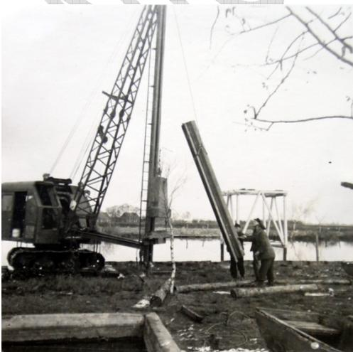
Um 1955 werden neue Spundwände eingezogen. Reste der Wände sind 1993 noch vorhanden. Das kleine Foto zeigt die Spundwand mit Startblöcken im Jahr 1982.
