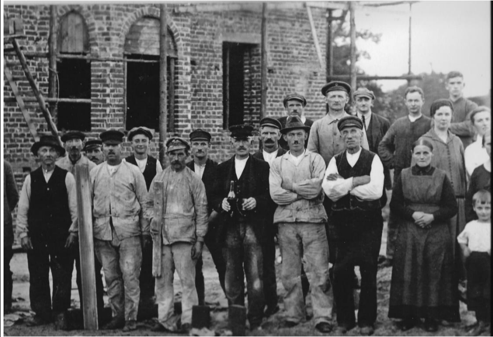
Nach dem Brand wird 1928 das Haus neu errichtet. Kastens hält die Arbeiter und die Bauherren-Familie (?) auf der Foto-Platte fest. [Repro: W. Meyer]
